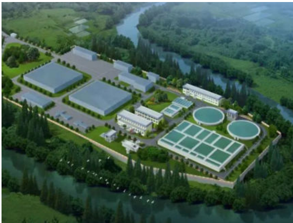
大竹县西城水厂建设项目
