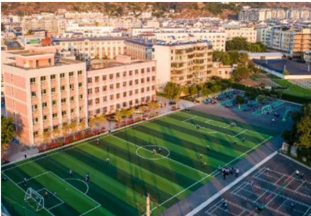
攀枝花市第九中学校教学综合楼维修加固项目
