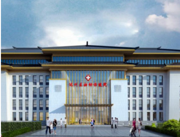
达川区妇幼保健院业务用房及附属设施建设项目 特殊科室及智能化建设
