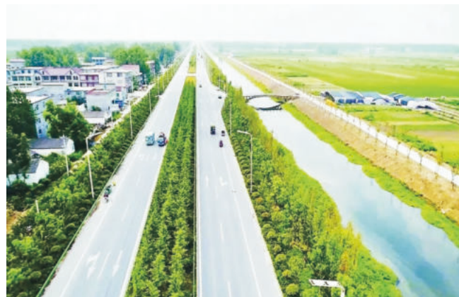
永新路西延先道路工程
