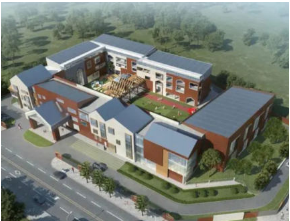
峨眉山市萌智幼儿园工程
