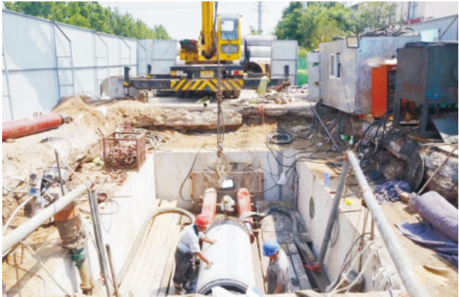
遂乐路道路建设项目
