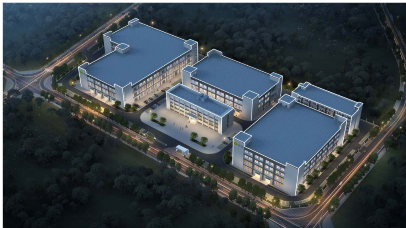
宜宾皓善新材料科技有限公司 1#、2#、3#厂房、办公楼、 宿楼及其附属工程
