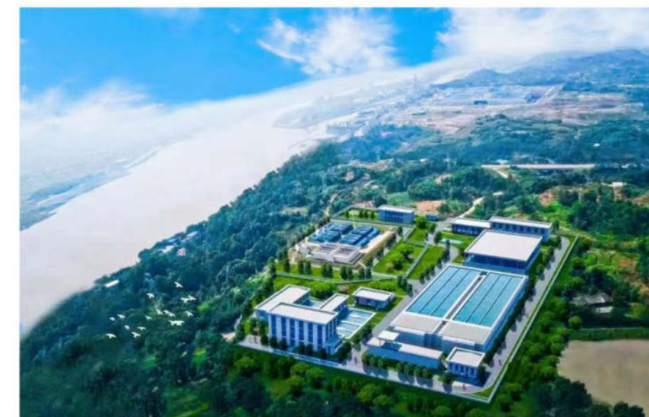
五通桥区工业供水二厂及配套管网工程项目监理
