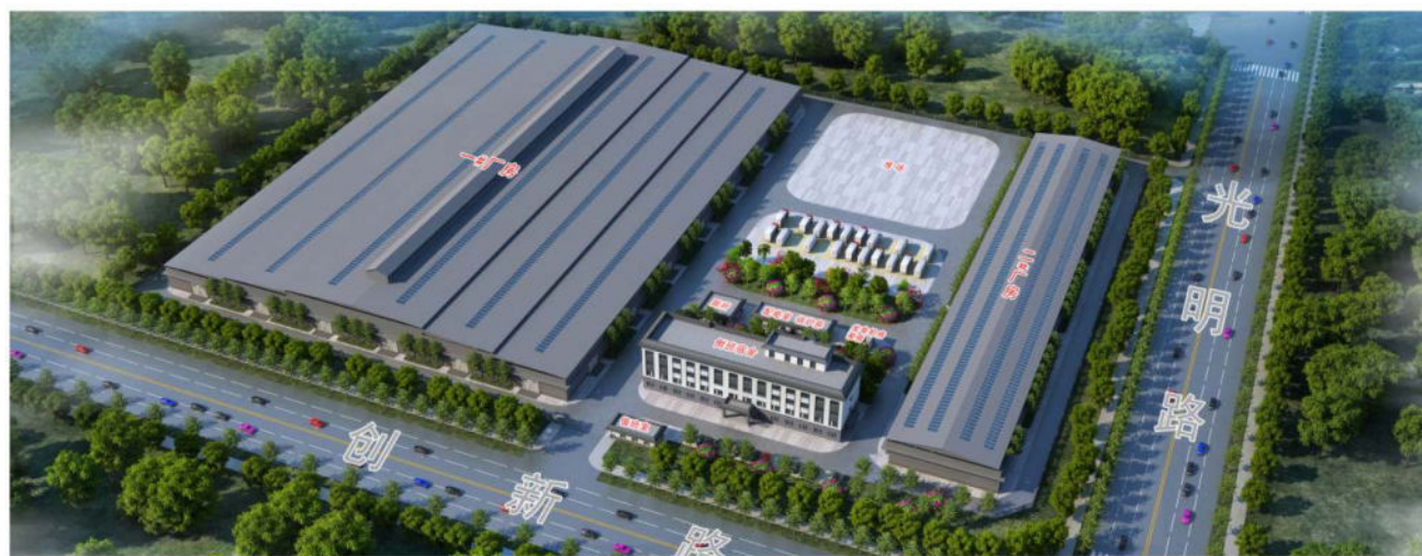
新疆德能钢结构有限公司钢结构加工及新能源光伏支架生产项目
