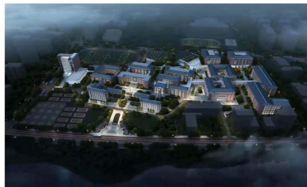
| 内江一中扩建项目监理
