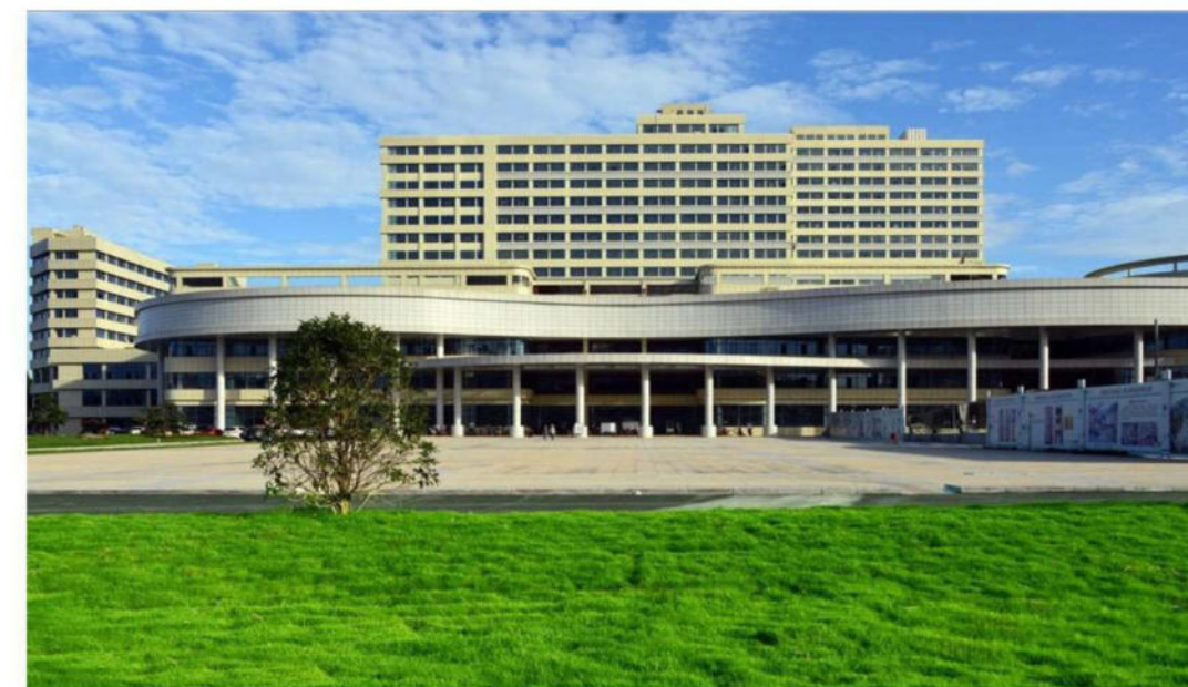
| 南部县人民医院整体迁建项目强弱电工程标段
