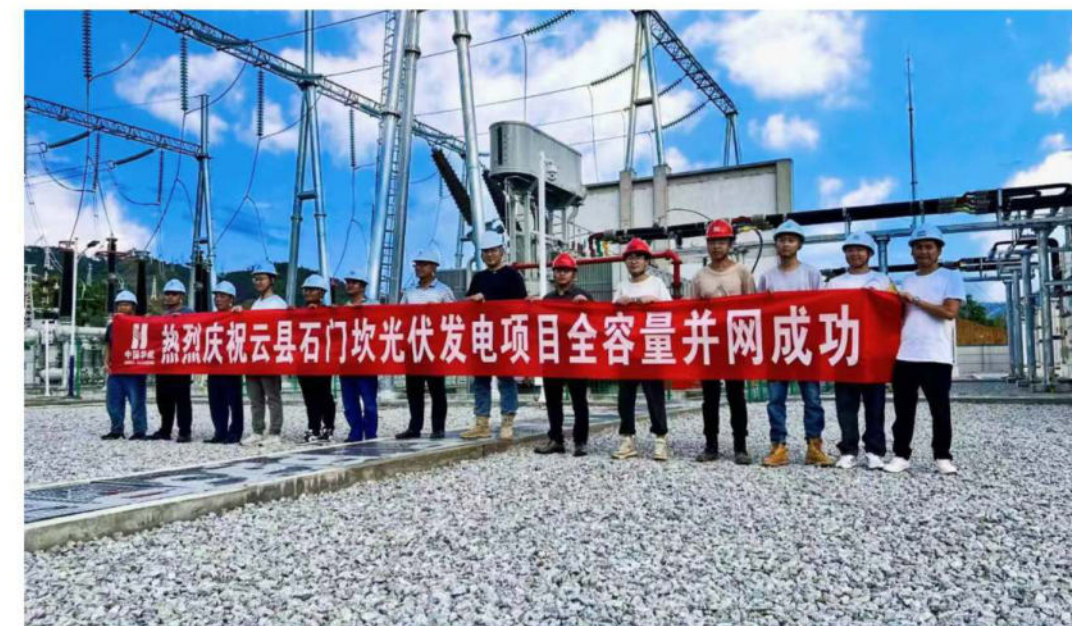
| 云南省临沧市云县石门坎农业光伏发电项目
