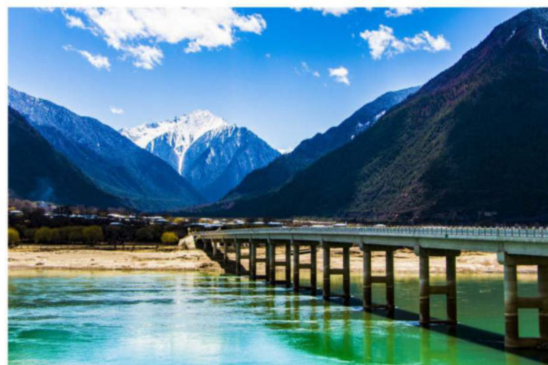
| 山南市雅砻河生态综合治理项目（一期）EPC项目监理
