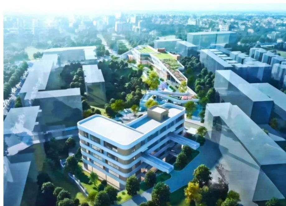
内江市东兴区外国语小学校扩建工程和附属幼儿园 建设项目 规模：8920m 2
