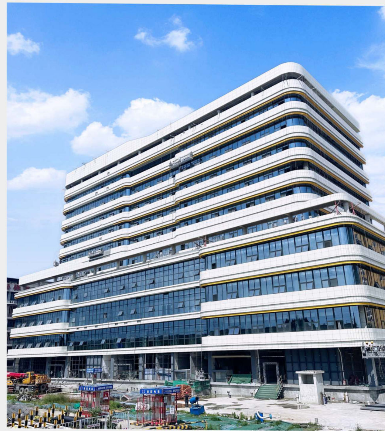
| 彭州市妇幼保健计划生育服务中心住院综合楼扩建项目
