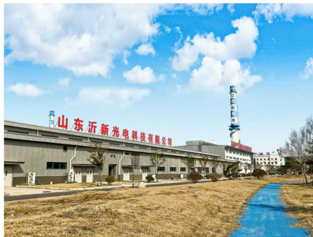
| 山东沂新光电科技有限公司精密电子玻璃项目
